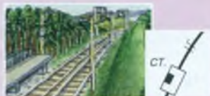
Двухпутная электрифицированная железная дорога. Станция
