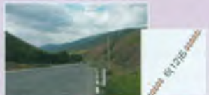
Автодорога с покрытием (6 — проезжая часть, 12 — ширина с обочиной в метрах, Б — бетонное покрытие), Насыль
